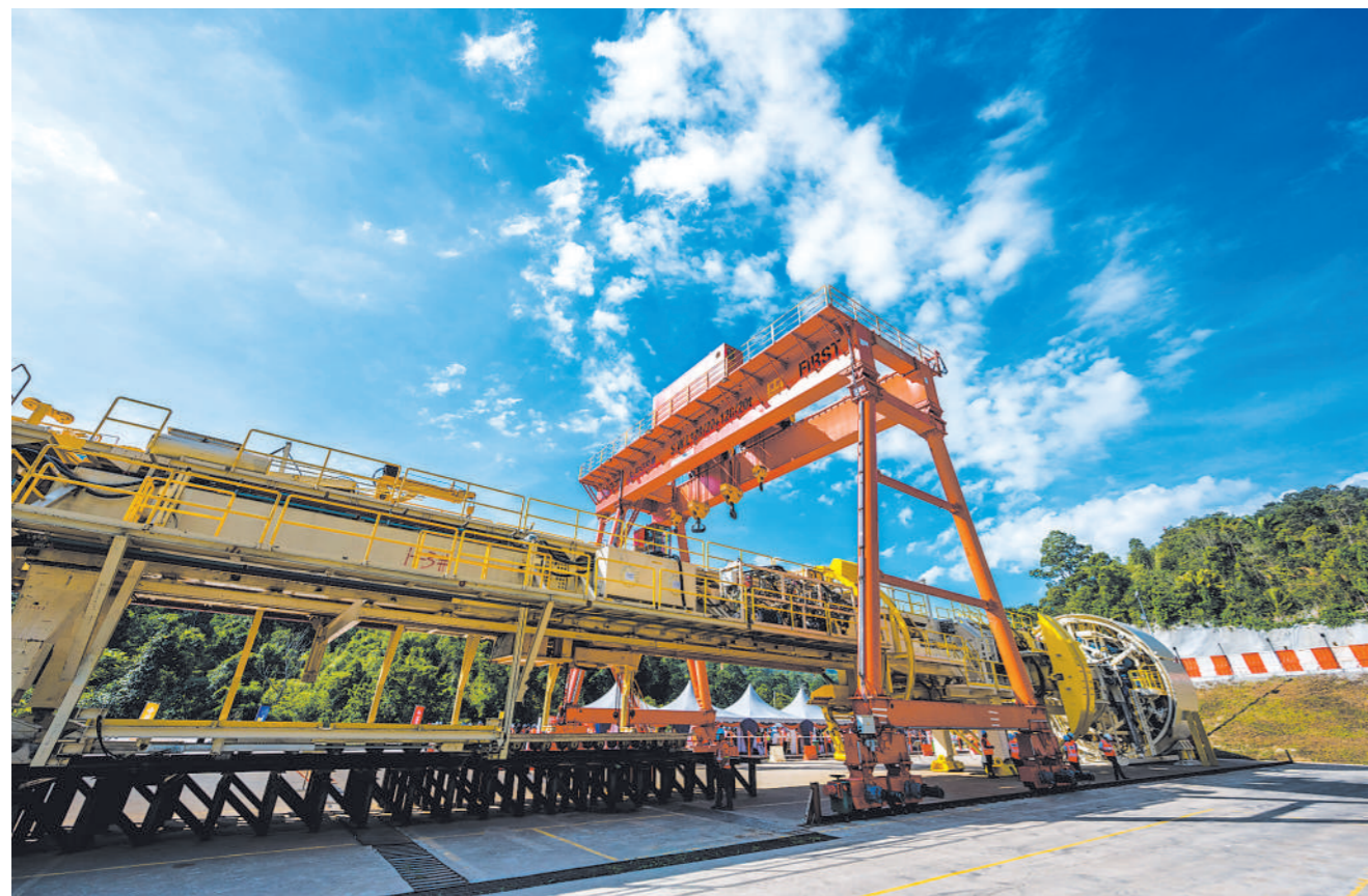
马来西亚交通部长魏家祥近日表示,中方建设者拥有丰富的经验和专业技术知识,使马来西亚东海岸铁路项目云顶隧道建设工地上拍摄的敞开式硬岩掘进机。
