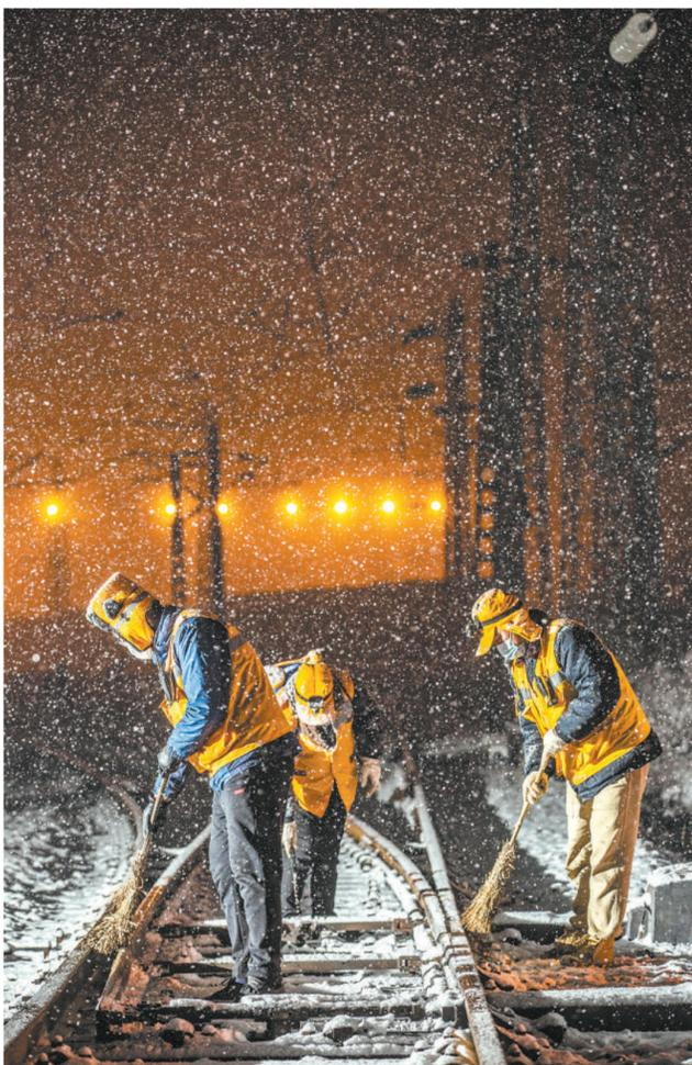
近日,我国多地出现降雪天气,铁路工人们“以雪为令”,坚守一线,采取多项措施,保障铁路运行无阻,确保春运安全畅通。图为1月21日深夜,在中国铁路郑州局集团有限公司新乡桥工段,铁路工人们冒雪清扫京广铁路新乡站道岔积雪。 新华社发
