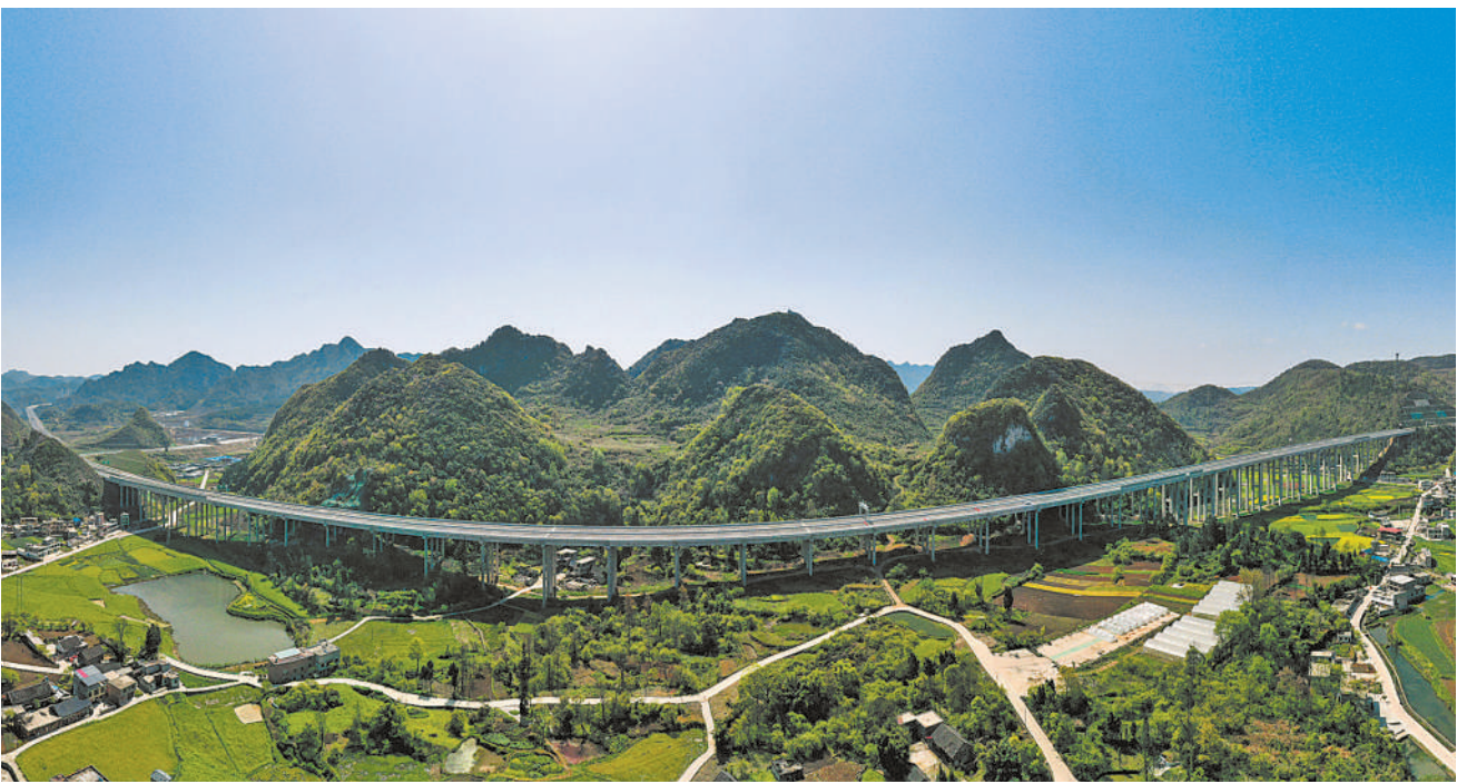
目前，由中交二公局和中交四公局承建的贵黄高速公路主线项目建设已进入收尾阶段，预计今年内全线贯通。贵阳至黄平高速公路项目主线全长120.6公里，是贵阳东出长三角经济区的便捷高速通道。图为3月28日拍摄的贵黄高速公路新民井特大桥（无人机全景照片）。 新华社记者 杨文斌摄
