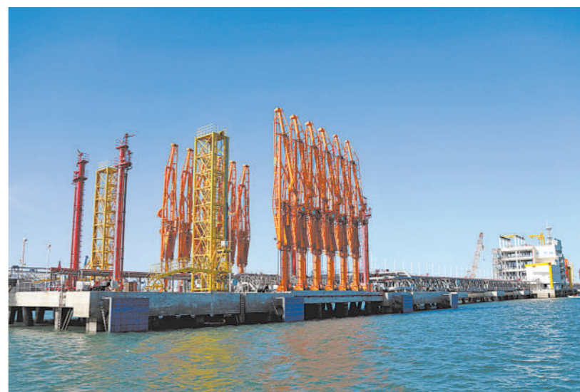
由中国交通建设股份有限公司承建的肯尼亚蒙巴萨油码头项目预计2022年4月交付使用。届时,肯尼亚将拥有一座具有国际领先水平的现代化油气装卸码头。图为近日拍摄的肯尼亚蒙巴萨油码头。
