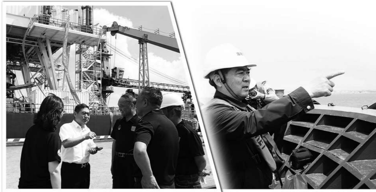
左图：窦正满（左二）在施工现场与工作人员交流。右图：窦正满在平潭海峡公铁两用大桥建设现场。 作者供图
