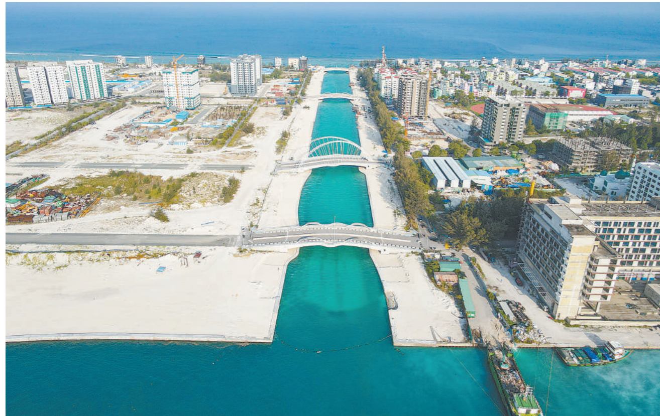
在由上千座小岛组成的马尔代夫，桥梁给当地民众带来无限希望：几年前中国援建的中马友谊大桥让马尔代夫实现拥有一座跨海大桥的梦想，如今中企在胡鲁马累岛承建的五桥项目被当地媒体形容为“开启了这个城市的新篇章”。这是3月24日在马尔代夫胡鲁马累岛拍摄的五桥项目中的四座桥。 新华社发
