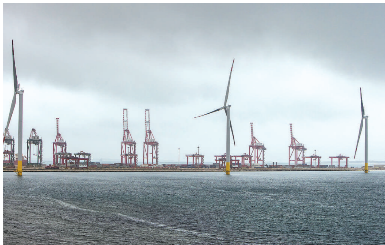
由中国公司提供关键设备的意大利莱奥利科海上风电项目4月21日在意大利南部港口塔兰托举行全容量并网仪式。据介绍，这是意大利首个海上风电项目，总装机容量为30兆瓦，可以满足近两万个家庭的用电需求。图为由中国公司提供的海上风力发电机组。
