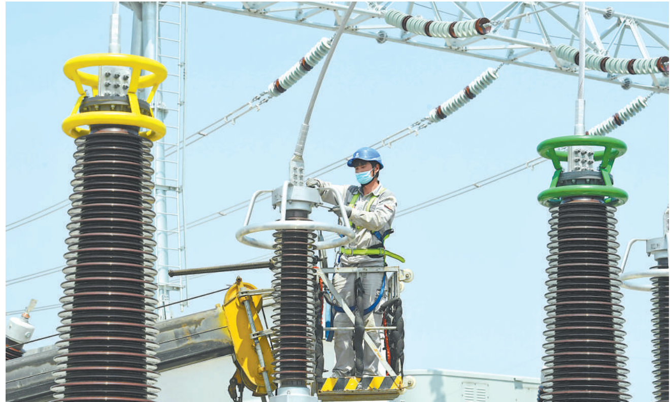
5月2日,在安徽省滁州市琅琊区220千伏林楼输电工程建设工地,电力建设者在安装设备。“五一”假期,许多劳动者依然坚守岗位,默默奉献。 新华社发
