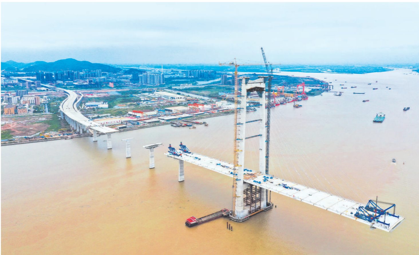
5月15日,由中铁大桥局施工的深中通道第100号60米混凝土箱梁在广东中山智慧梁场浇筑完成。 深中通道是集“桥、岛、隧、水下互通”于一体的超大型跨海集群工程,全长约24公里,计划今年10月完成全部混凝土箱梁的预制,为深中通道2024年建成通车奠定基础。图为正在进行箱梁架设的深中通道中山大桥建设现场(5月15日摄)。 新华社记者 刘大伟 摄
