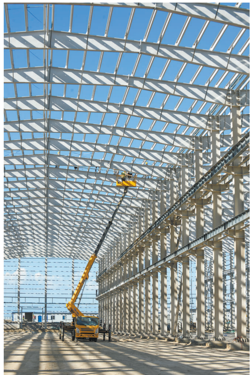
进入施工旺季,新疆塔城重点开发开放试验区工程建设有序进行,工人昼夜奋战在建设现场。塔城重点开发开放试验区是我国西北地区第一个沿边重点开发开放试验区。这是试验区正在建设的国际物流园项目钢结构加工厂房(5月18日摄)。 新华社记者 高 晗摄
