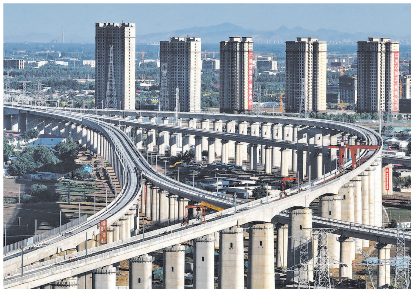
近日,京唐城际铁路建设正在按照节点要求扎实推进。京唐城际铁路是国家重点工程,也是京津冀城际轨道交通网络的重要组成部分,起自北京城市副中心站,终止于河北省唐山市唐山站,正线线路全长148.7公里。图为6月7日,工人在唐山市高新技术开发区境内的京唐城际铁路建设工地施工。
