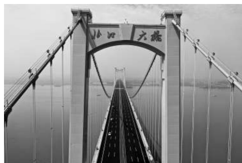
5月27日，位于浙江温州境内的甌江北口大桥建成通车，标志着连接浙闽粤三省的沿海大动脉——甬莞高速全线正式通车。 新华社发
