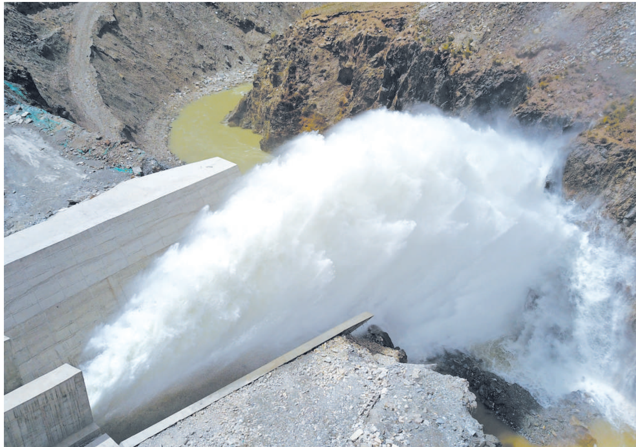
蓄集峡水利枢纽工程位于青海省海西蒙古族藏族自治州德令哈市境内,为巴音河干流上骨干调蓄工程,也是柴达木循环经济试验区的重点水源工程。这是6月8日拍摄的蓄集峡水库放空洞泄流景象(无人机照片)。
