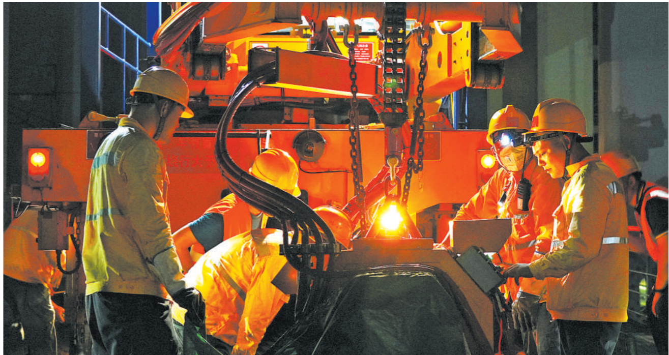
7月12日，中国铁路上海局集团有限公司检修人员，在大胜关长江大桥上对高铁线路铁轨进行维修。近日，全国多地持续高温，许多劳动者不畏炎热，坚守岗位，保障生产和人民生活。
