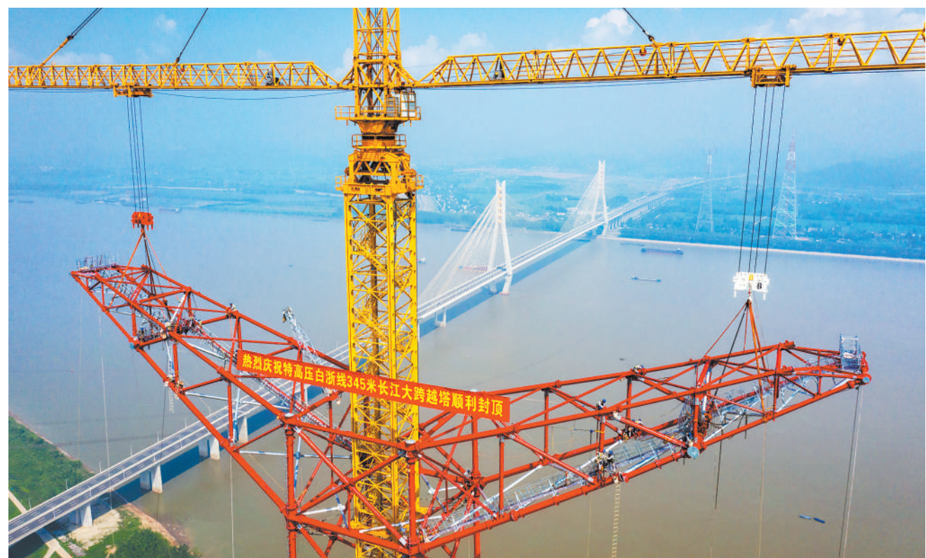
8月1日，经过建设者150余天的奋战，白鹤滩至浙江±800千伏特高压直流输电工程安徽池州长江大跨越345米的南岸跨越塔成功封顶。白浙线是我国实施“西电东送”战略的重点工程，送端连接目前世界在建最大水电站白鹤滩水电站，受端位于杭州临平区西北换流站，线路全长2140.2公里。
