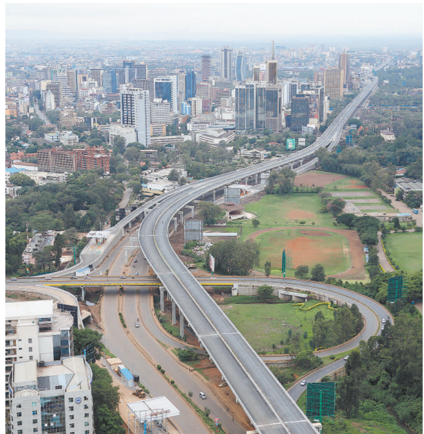
由中国路桥工程有限责任公司投资开发和建设运营的肯尼亚首都内罗毕快速路7月31日正式投入运营。肯尼亚总统肯雅塔在出席相关仪式时，称赞中企承建的道路项目大力帮助解决内罗毕交通堵塞的状况。这是2022年5月8日拍摄的内罗毕快速路的资料照片。 新华社发
