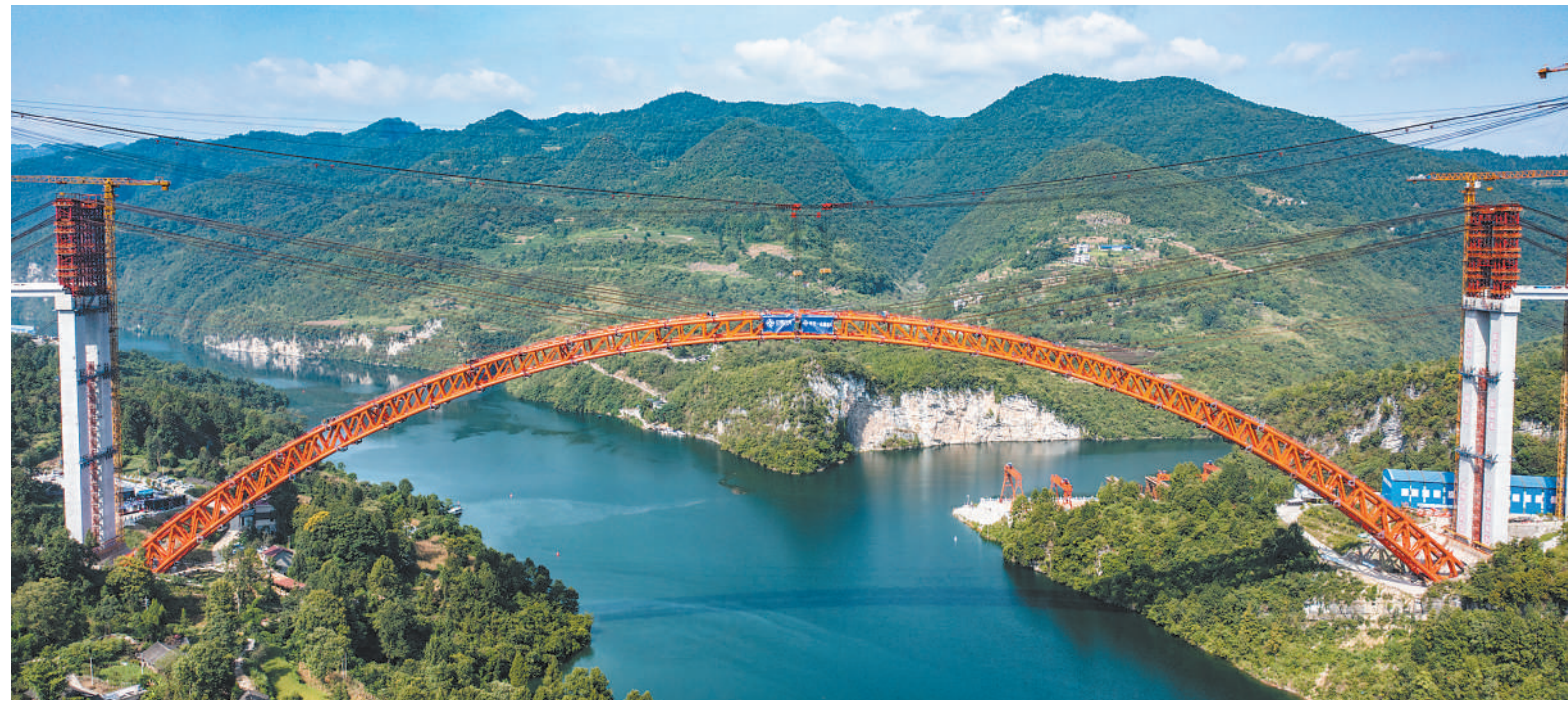
8月15日,由中交一公局承建的德余高速乌江特大桥顺利合龙。乌江特大桥是德江至余庆高速公路的重要控制性工程,大桥全长1834米,主桥为504米上承式钢桥混凝土拱桥。新华社记者陶亮摄
