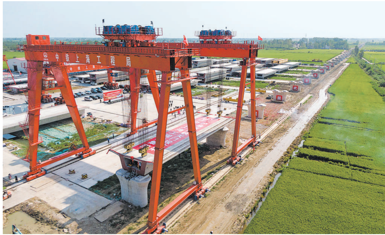
8 月 25 日, 沪渝蓉高铁天门段首榀箱梁成功架设。沪渝蓉高铁武汉至宜昌段位于湖北省境内, 沿线经武汉、孝感、天门、荆门至宜昌, 是我国“八纵八横”高速铁路主通道之沿江通道的重要组成部分。新华社记者 熊琦摄
