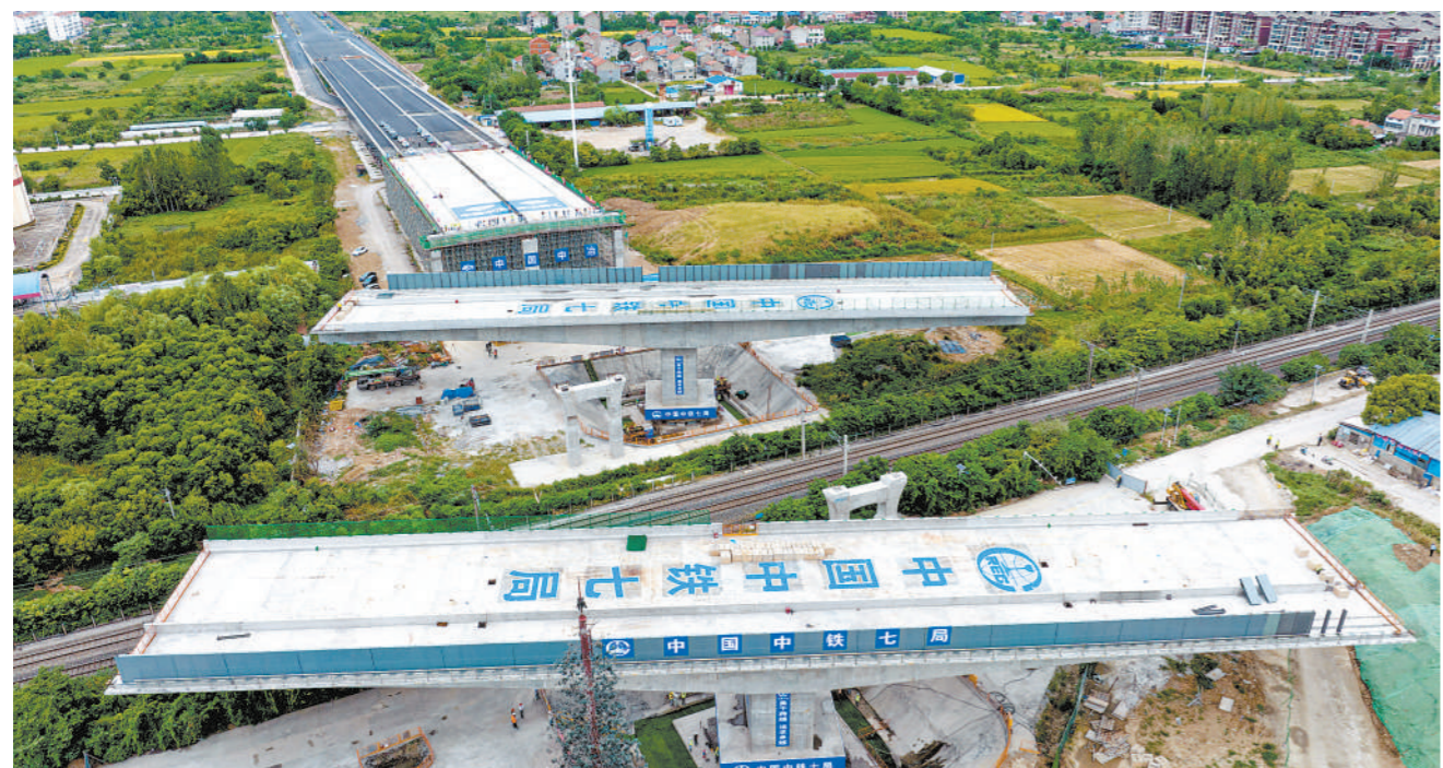
8月30日,由中铁七局承建的湖北省孝感市孝云大道长兴三路延伸工程跨京广铁路的两座万吨桥梁成功转体。每座转体桥梁长114米,宽20.5米,重量约为1万吨。图为桥梁转体“跨越”京广铁路施工场景。新华社记者 肖艺九摄
