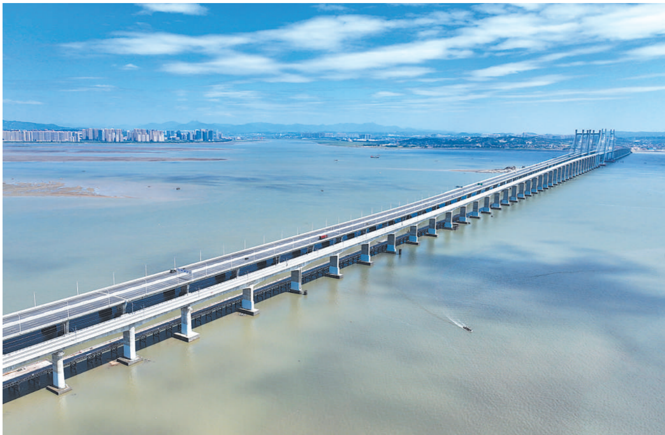
近日,新建福州(厦)门铁路加紧施工。图为9月2日拍摄的新建福州厦铁路泉州湾跨海大桥(无人机照片)。
