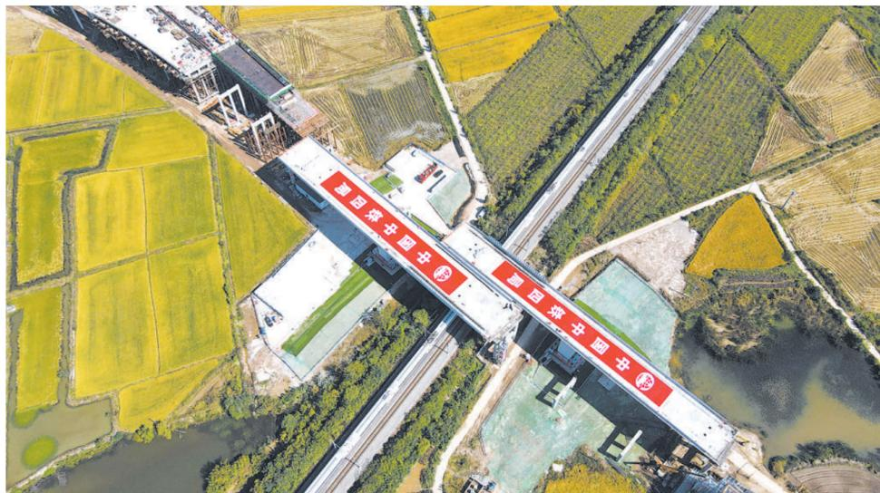
10月12日,由中铁四局承建的明(光)巢(湖)高速上跨沪蓉铁路万吨双幅转体桥体成功,顺利跨越沪蓉铁路,为明巢高速全线按期通车提供了保障。图为当日一列动车从完成转体的明巢高速双幅转体桥下穿过。新华社记者 刘军喜摄
