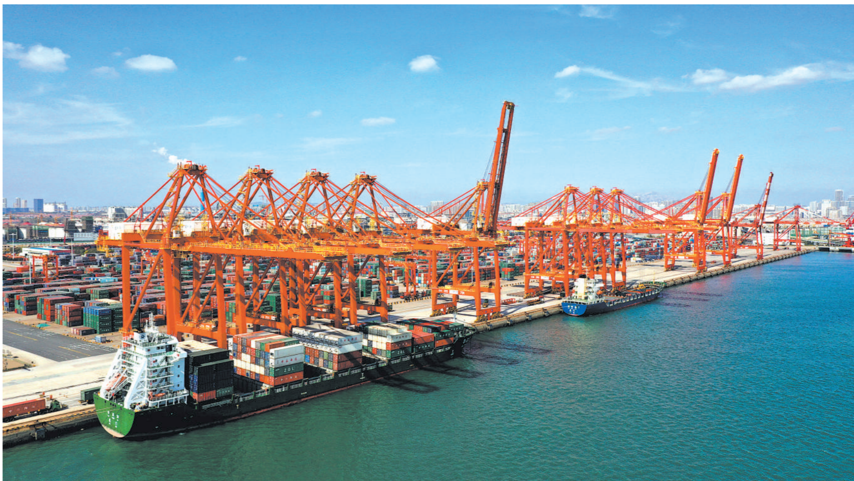
山东港口日照港1-9月完成货物吞吐量37371万吨,同比增长7.2%;集装箱吞吐量426万标箱,同比增长11%,呈现出稳中向好的态势。图为10月28日在日照港集装箱码头拍摄的作业场景(无人机拍摄)。
