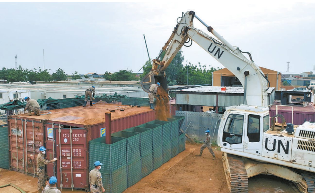
近日,中国第10批赴马里维和工兵分队高标准完成联马团东战区掩体建设任务。图为我维和官兵在施工现场装填沙箱。 葛禹再摄
