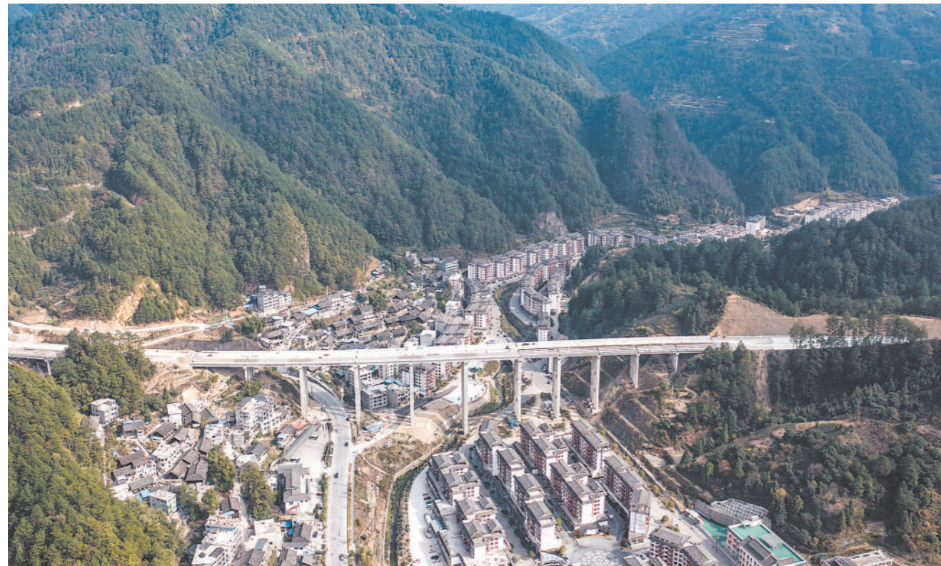
建设中的雷榕高速雷山至大塘路段(11月15日摄)。贵州雷山至榕江高速公路建设项目正加紧施工,抢抓项目建设进度。雷榕高速起于雷山县城东,止于榕江县城北的忠诚枢纽互通,与剑榕高速公路相接,全长72.453公里。
