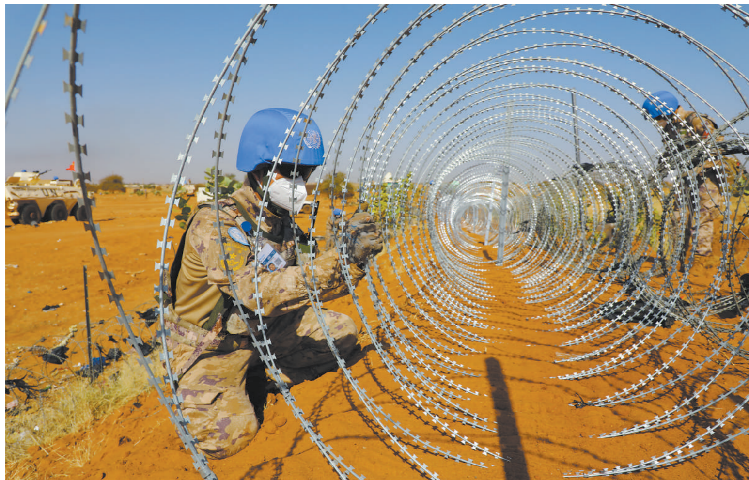
近日,中国第10批赴马里维和工兵分队与防卫步兵分队,高标准完成联合国加奥超营外国国防设施修复任务,得到联马团高度评价。图为我维和官兵在施工现场架设铁丝网。葛禹禹摄
