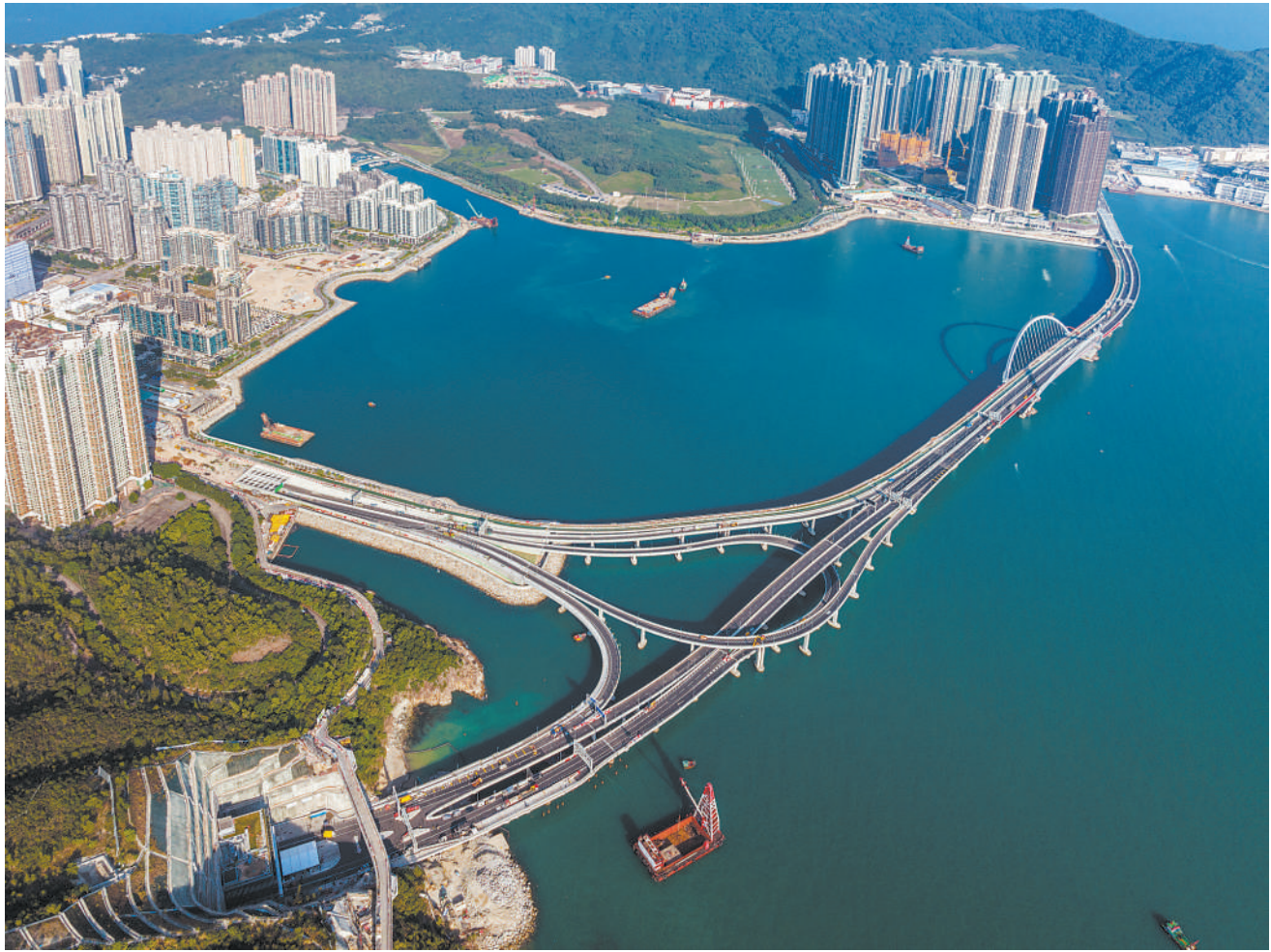
香港将军澳跨湾大桥12月11日正式通车。这是8日拍摄的香港将军澳跨湾大桥(无人机照片)。
