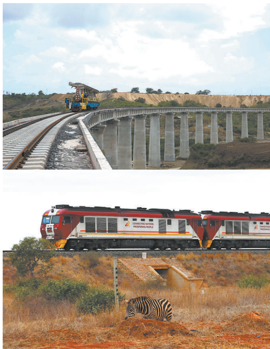
蒙内铁路是中非合作论坛约翰内斯堡峰会确定的“十大合作计划”的重要成果,连接东非第一大港口蒙巴萨和肯尼亚首都内罗毕,全长约480公里,是一条采用中国标准、中国技术、中国装备建造的现代化铁路。截至2022年12月,蒙内铁路旅客运输量已超过878万人次,货运量达到2269万吨。 上图:这是2016年9月1日在肯尼亚蒙巴萨拍摄的建设中的蒙内铁路蒙巴萨特大桥项目。 下图:2022年7月28日,在肯尼亚察沃,一匹斑马在蒙内铁路行驶的列车附近吃草。 均由新华社发
