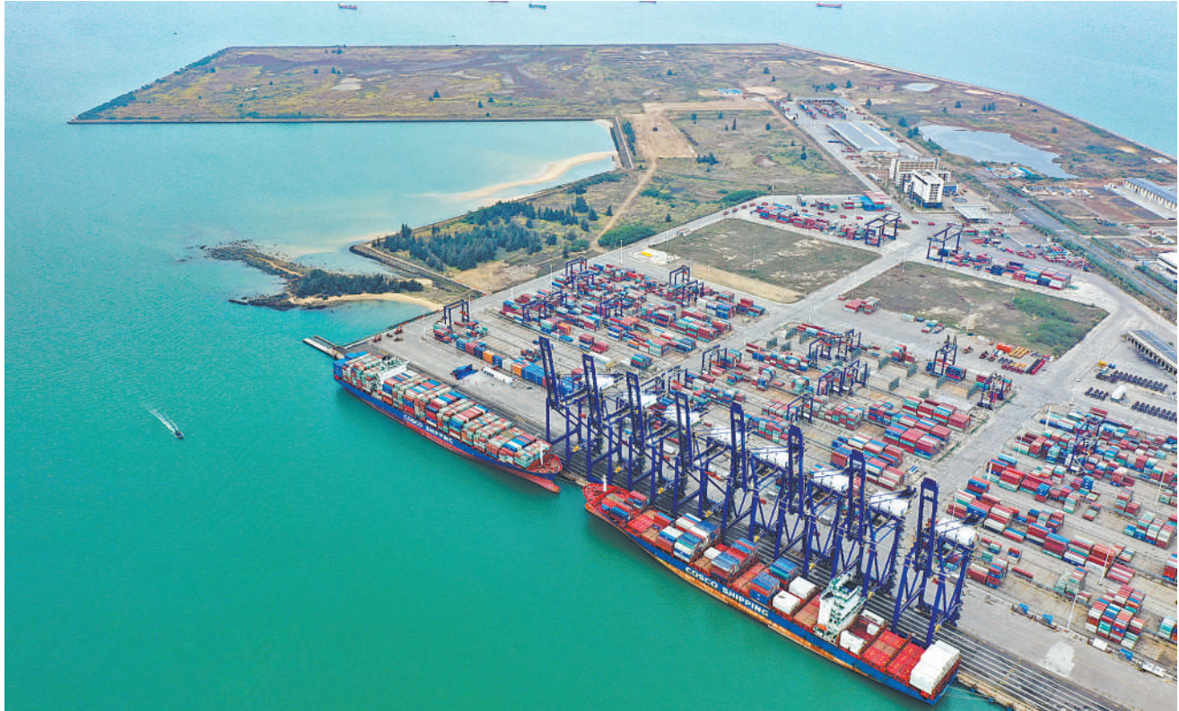
1 月 11 日,海南洋浦区域国际集装箱枢纽港扩建工程开工仪式在洋浦国际集装箱码头举行。该工程是服务打造西部陆海新通道的一项重要工程,将新建 4 个 20 万吨级、1 个 15 万吨级集装箱泊位。
