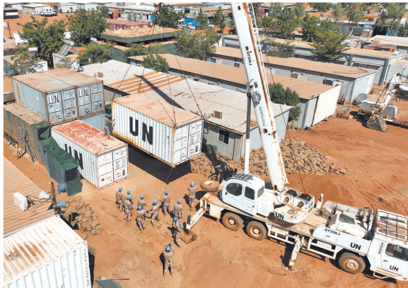
1月30日,经过41天紧张施工,中国第10批赴马里维和工兵分队高标准完成联马团东战区约旦地勘分队营区建设任务。图为我维和官兵在施工期间进行吊装作业。 葛学禹摄
