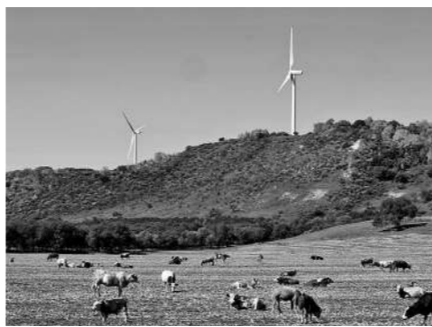
近年来,河北省着力构建新型电力系统,实现新能源增长、消纳和储能协调发展,为能源产业低碳转型贡献力量。
