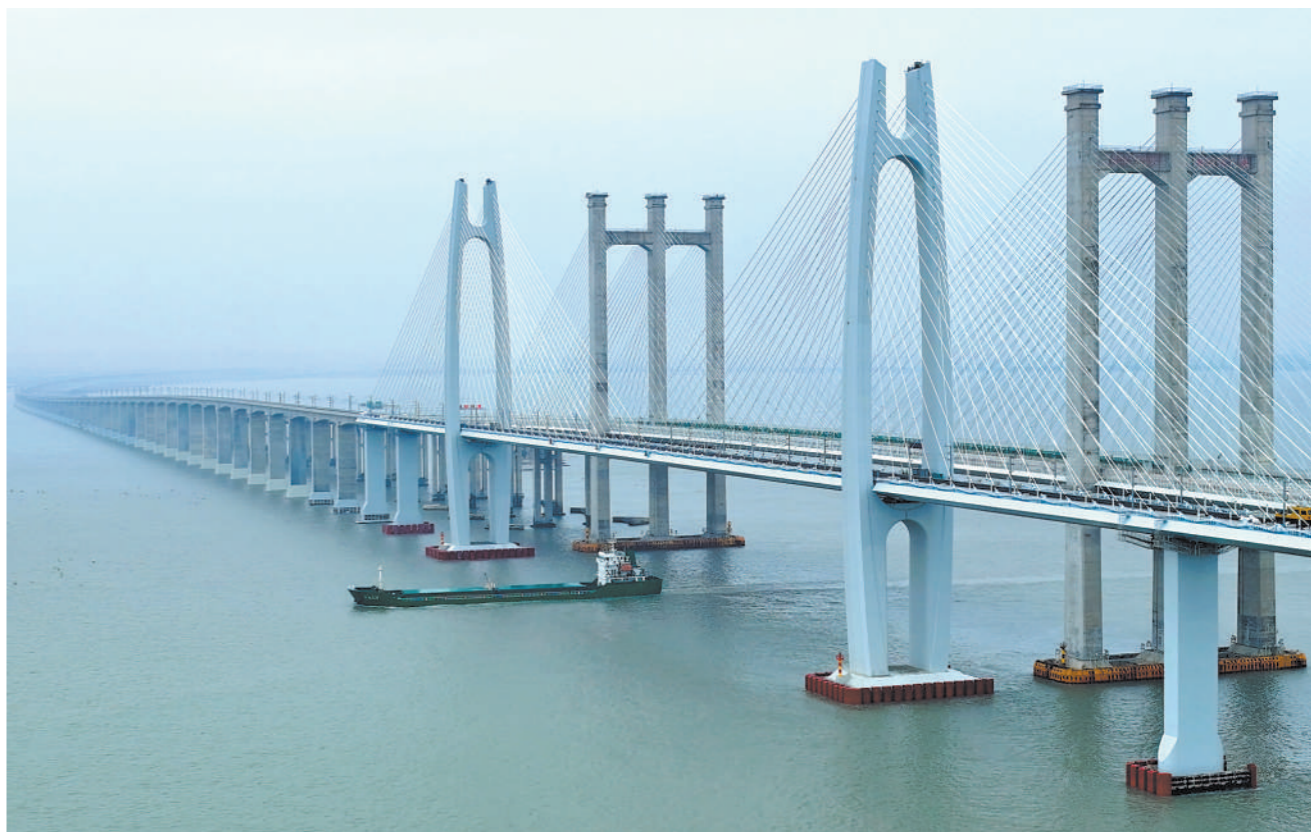
2月3日，我国首条跨海高铁——福厦高铁进入静态验收阶段，标志着该高铁全线主体工程及其配套工程建设已基本完成，距离线路今年开通运营更进一步。图为2月4日拍摄的新建福厦铁路泉州湾跨海大桥(无人机照片)。 新华社记者 魏培全摄
