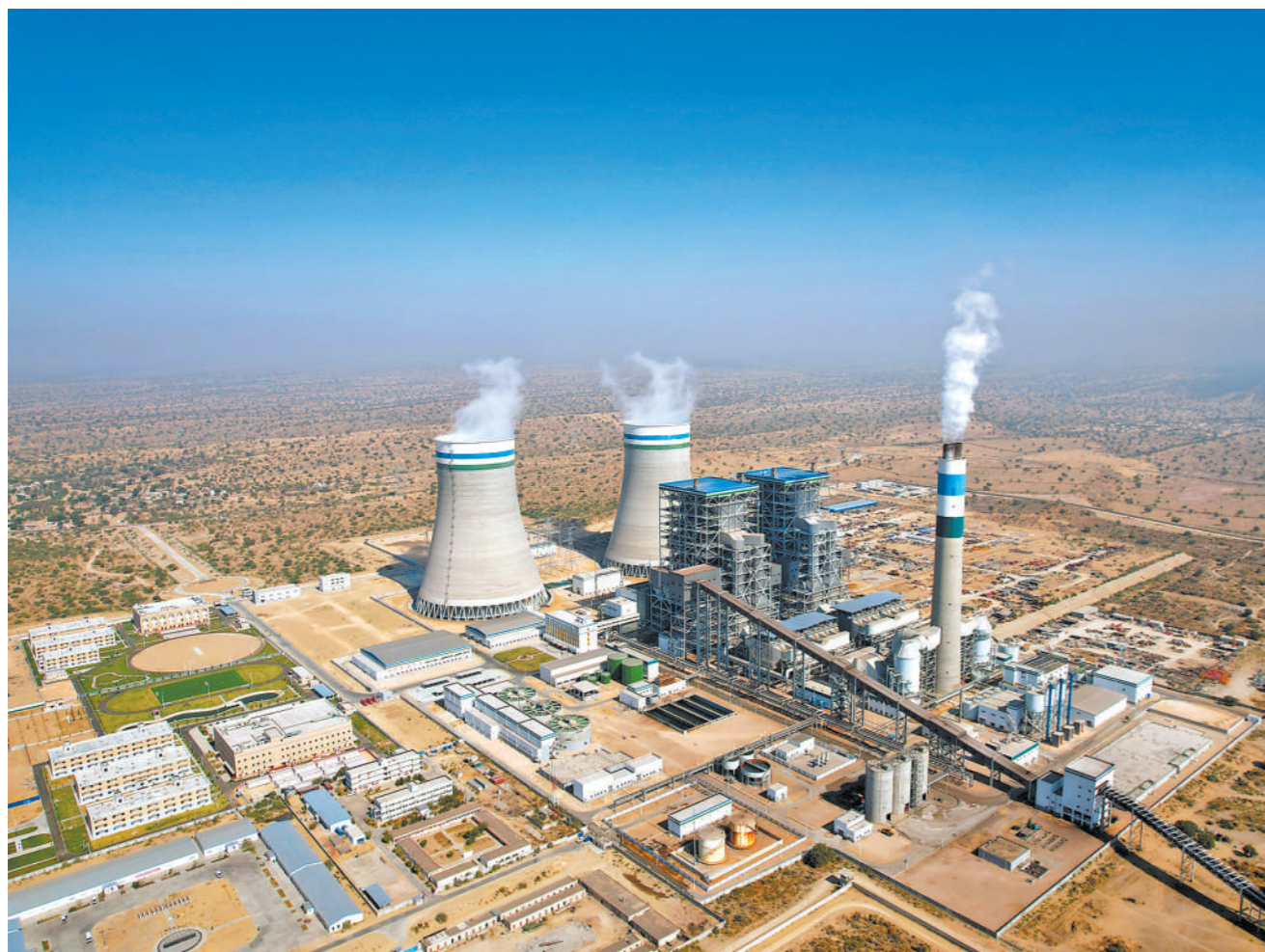
这是2月4日航拍的巴基斯坦塔拉尔煤田一区块煤电一体化项目中的燃煤电站。巴基斯坦塔拉尔煤田一区块煤电一体化项目中的燃煤电站项目5日正式投入商业运行。该煤电一体化项目位于巴基斯坦南部信德省塔尔地区，是中巴经济走廊框架下的能源合作重点项目，由上海电气集团股份有限公司自主开发、建设、运营。项目于2019年开工建设，包括年产量780万吨褐煤的露天煤矿及一座拥有两台660兆瓦高参数超临界火力发电机组的燃煤电站。 新华社发
