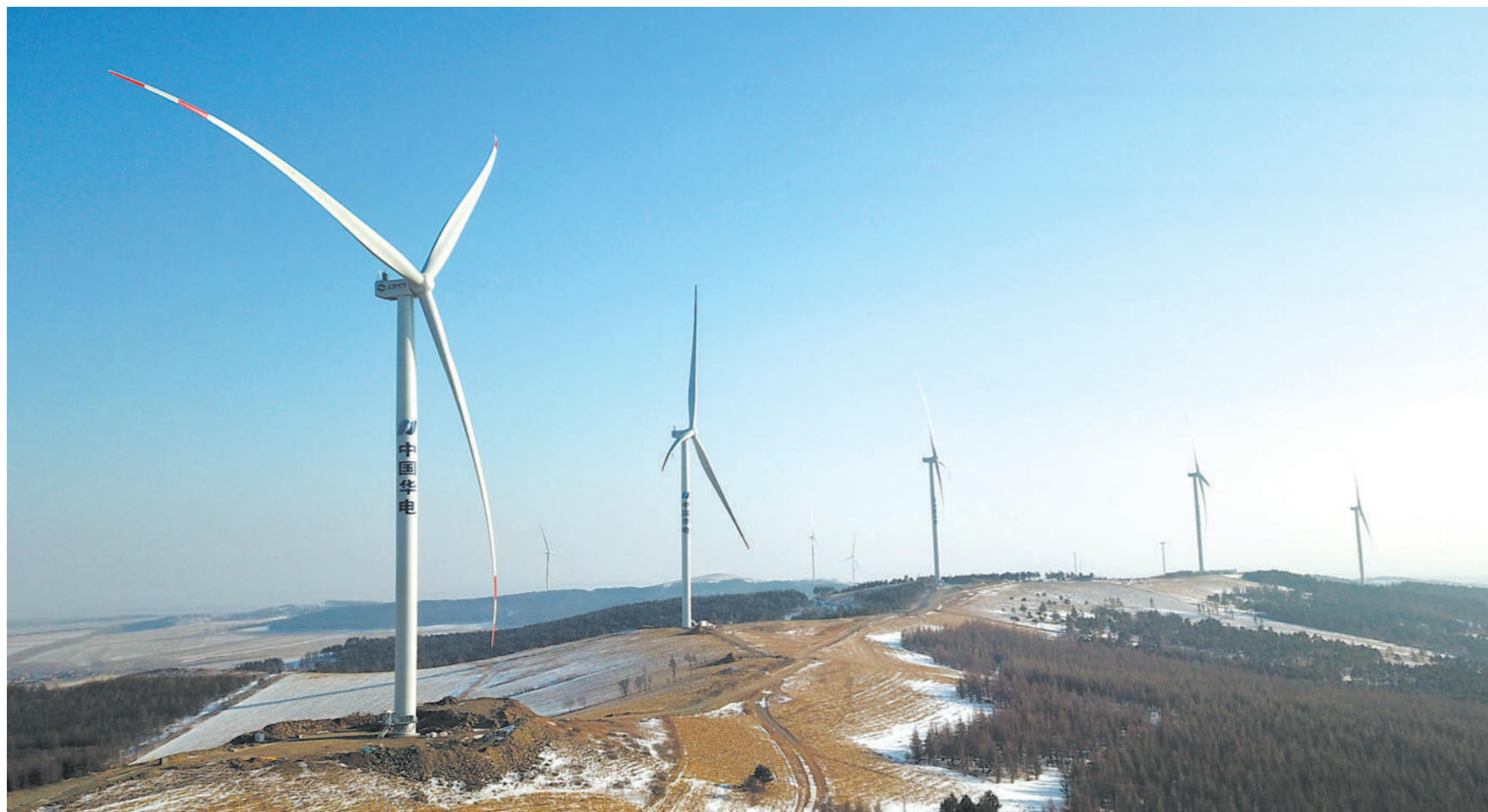
华电黑龙江区域哈尔滨依兰鸡冠山风电场三期工程的风电机组，正在运行和建设中。这个工程安装的24台6.25兆瓦风电机组，是目前黑龙江省内单机容量最大的风电机组。图为2月7日拍摄的该工程风电机组。新华社记者 王建威摄
