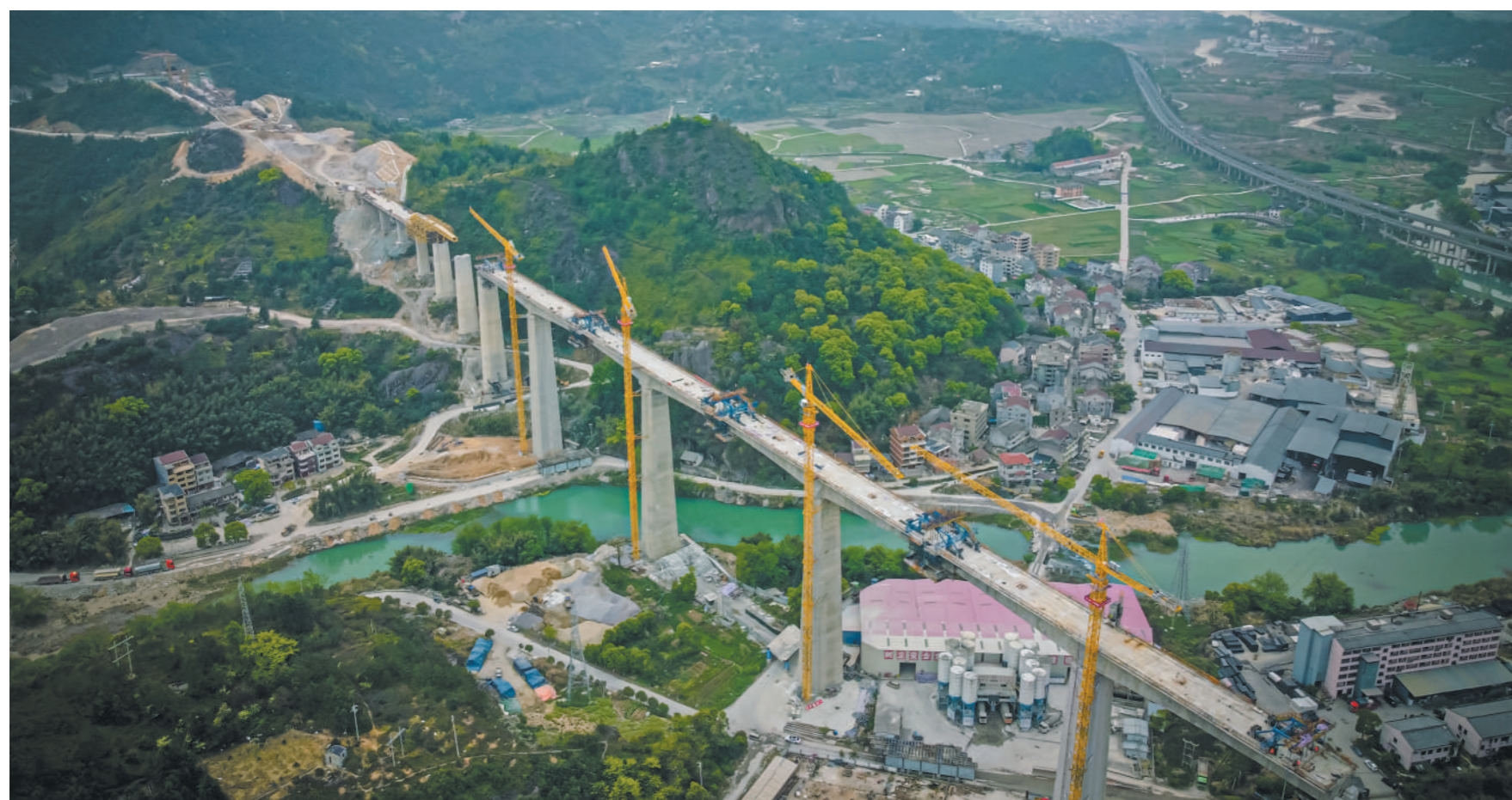
4月1日以来,杭温铁路(杭州至温州高速铁路)控制性工程建设取得重要进展,先后实现了陡门溪特大桥连续梁合龙与麻谷岭隧道全线贯通。杭温铁路设计时速350公里,建成后 will 增强区域干线高速铁路网,构建浙江省“1小时交通圈”。
