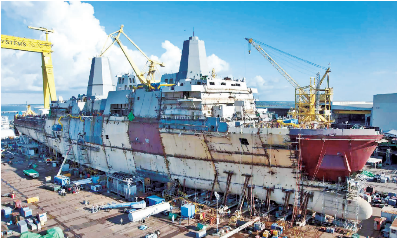
正在建造的LPD型两栖运输舰
