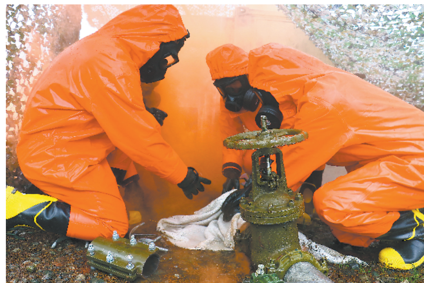
1月4日,西宁联动保障中心某输油管线团官兵拉至陌生地域,开展野战输油管线保障演练,确保“战场血液”畅通。图为参演官兵在对“受损管线”进行维修。
