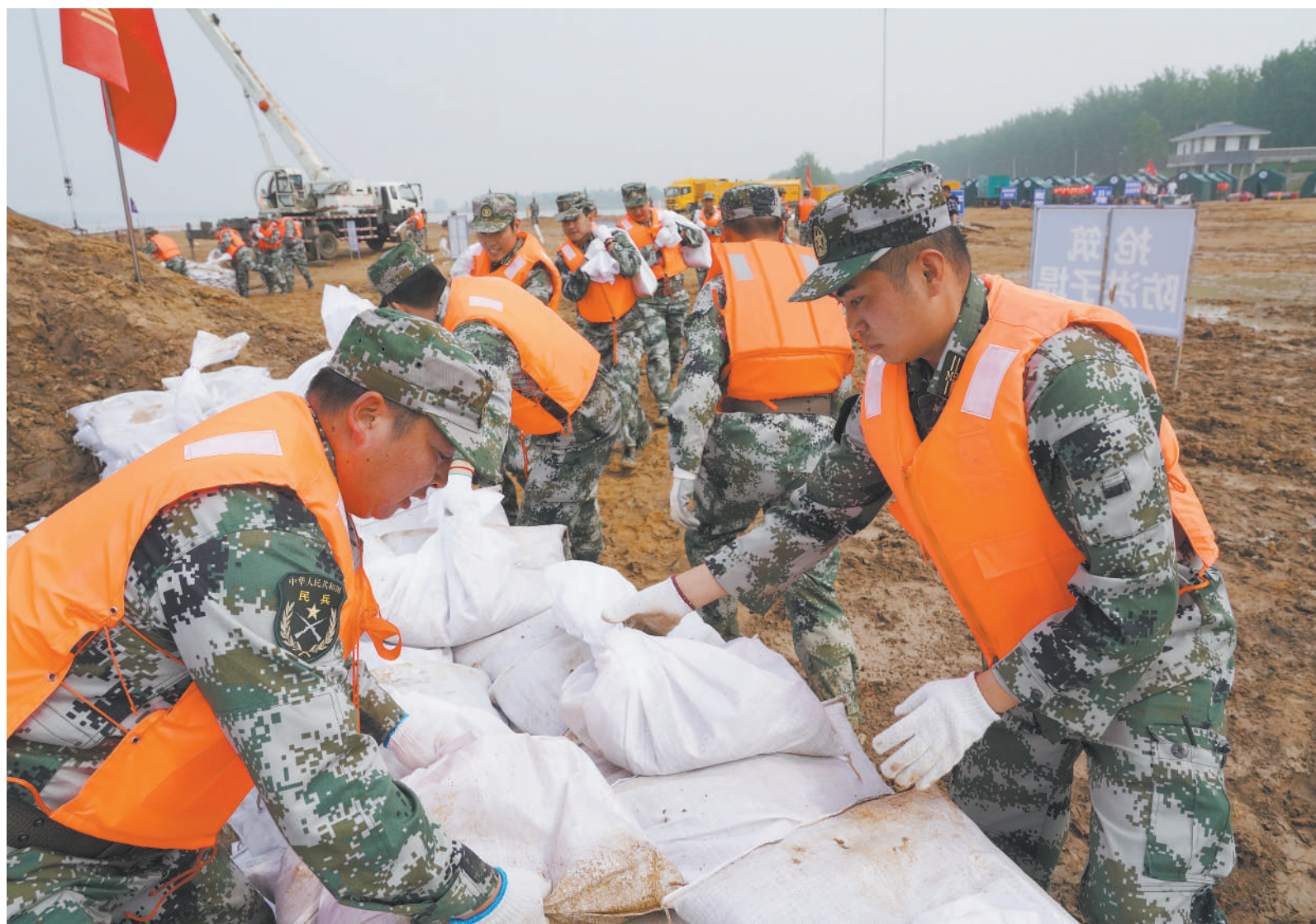
近日,为应对即将到来的汛期,江苏省徐州军分区组织驻地防务应急演练,旨在进一步健全完善防汛应急响应工作机制,提高应急响应抢险救援能力。图为民兵应急响应分队正在装填沙袋,构筑防洪堤。胡绍武摄
