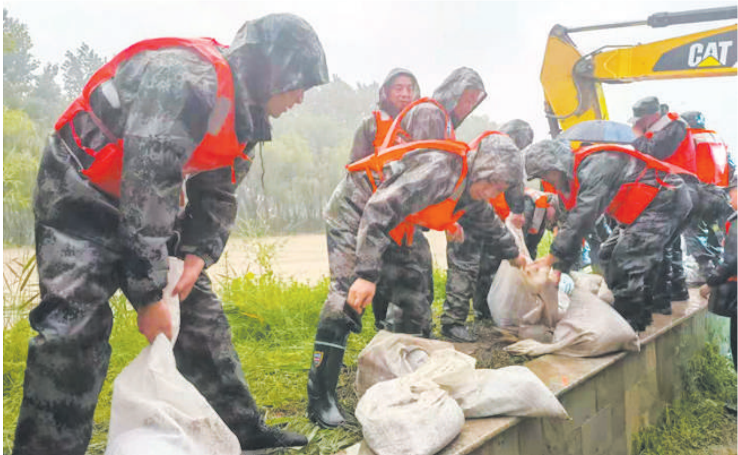
7月20日,河南省郑州市惠济区人武部民兵奋战在黄河大堤固堤抢险。连日来,河南多地持续遭遇强降雨,郑州等城市发生严重内涝,一些河流出现超警水位,防汛形势十分严峻。郑州警备区闻令而动,党员骨干站前排、当先锋、担重任,冲锋在抗洪抢险一线。
