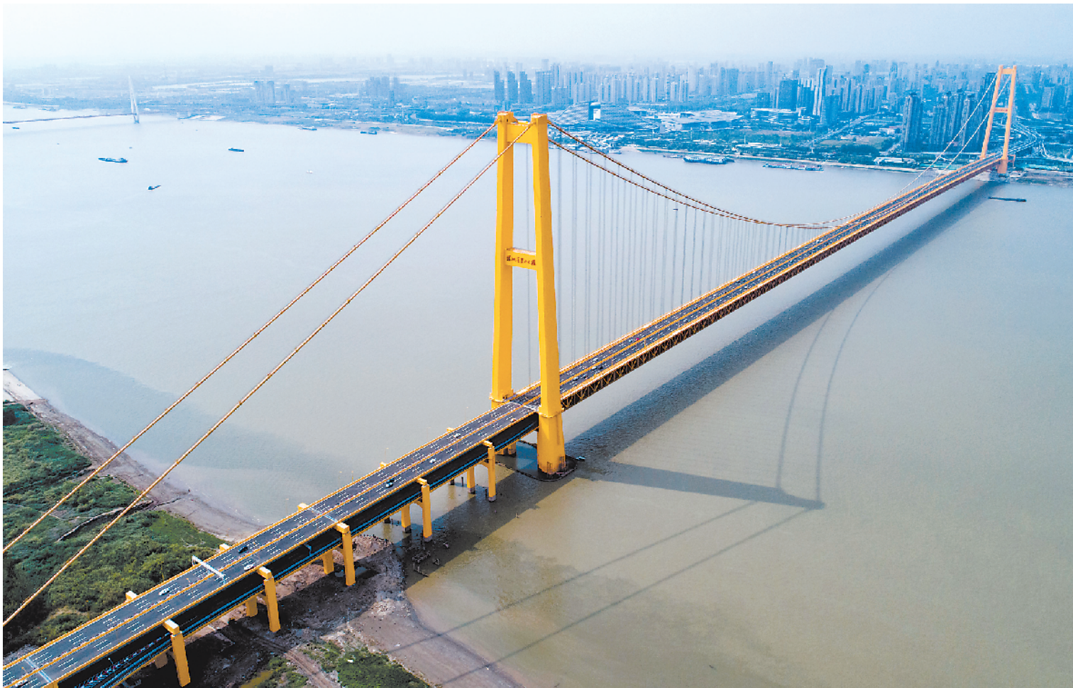
10月8日，长江上首座双层公路大桥——武汉杨泗港长江大桥正式投入使用。杨泗港长江大桥全长4.13公里，主跨1700米，一跨过长江。大桥上层为城市快速路，下层为城市主干道。图为无人机拍摄的武汉杨泗港长江大桥。
