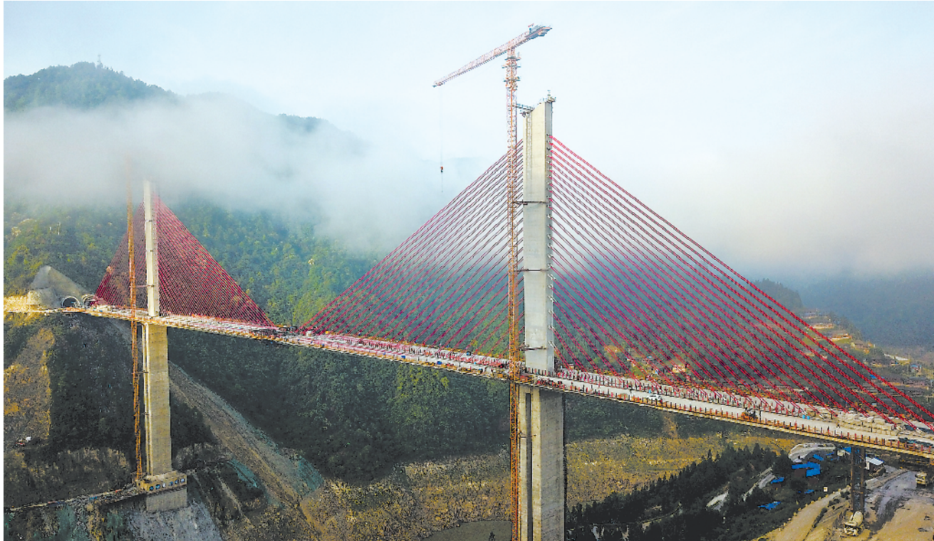
4 月 28 日,贵州剑河至榕江高速公路控制性工程——清水江特大桥顺利合龙。图为大桥合龙场景。
