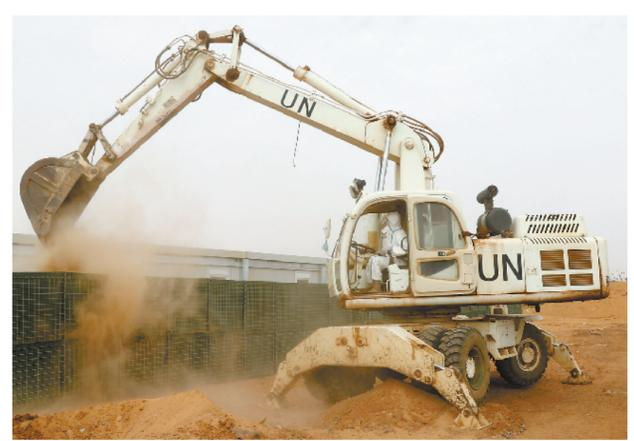
当地时间6月1日,中国第7批赴马里维和工兵分队梅纳卡分队完成尼日尔维和分队营区构筑防爆墙任务。图为我维和官兵操作机械装填防爆沙箱。
