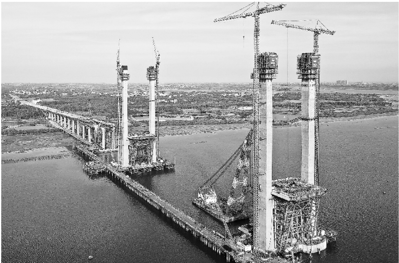
广东湛江调顺跨海大桥全长约9.36公里，建成后将对接粤港澳大湾区，加快广东粤西片区经济发展。图为7月18日调顺跨海大桥完成西主塔封顶。
