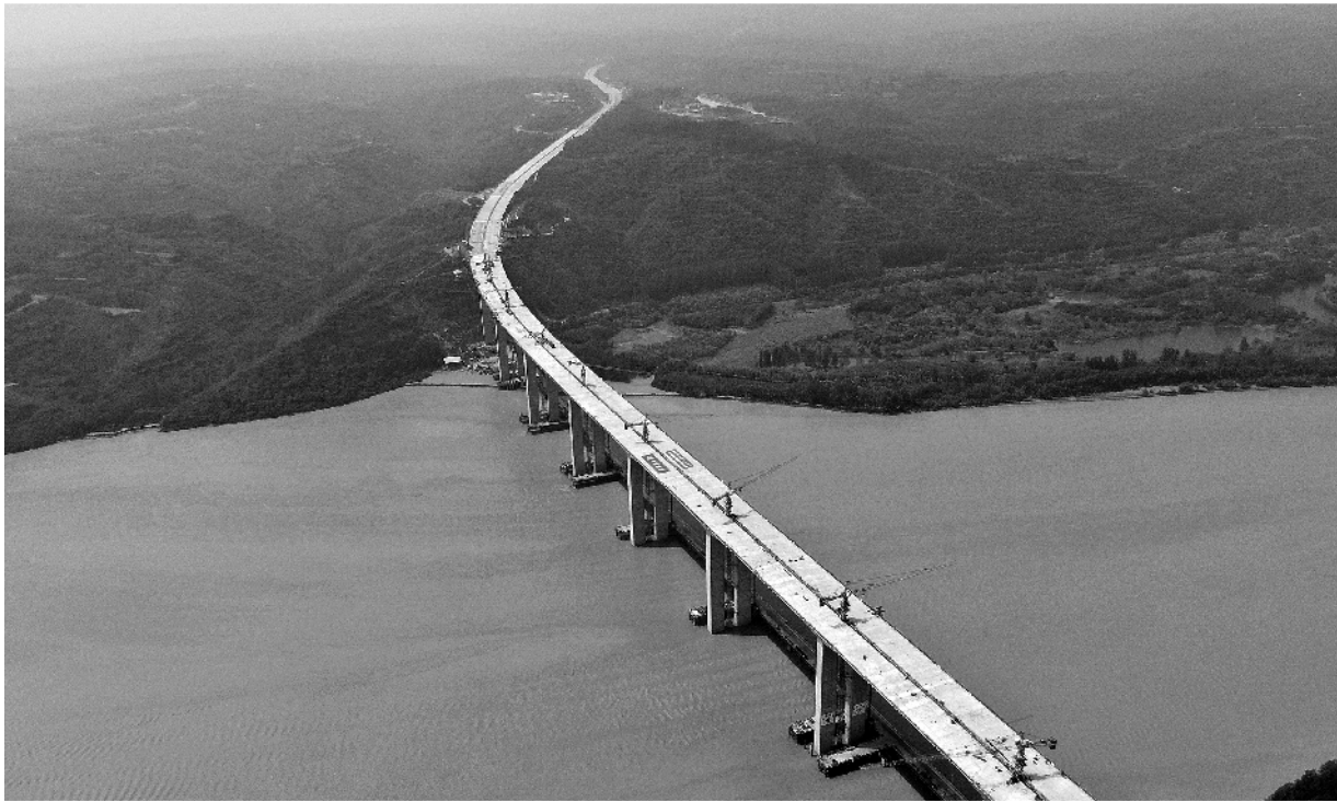
河南济(济源)洛(洛阳)西高速铁路黄河特大桥,是沟通洛河与济源的重要通道。日前,大桥主体工程完工,进入最后的桥面铺设和桥梁护栏建设阶段。新华社记者 郝源摄
