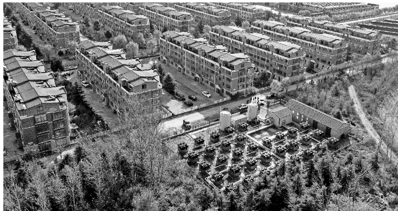
2020年,山东省完成35.84万户“煤改电”清洁采暖工作,采暖季预计节约标煤27万吨,减排二氧化碳68万吨。图为山东省威海市文登区金岭山庄清洁能源供暖站。新华社记者 朱峥摄
